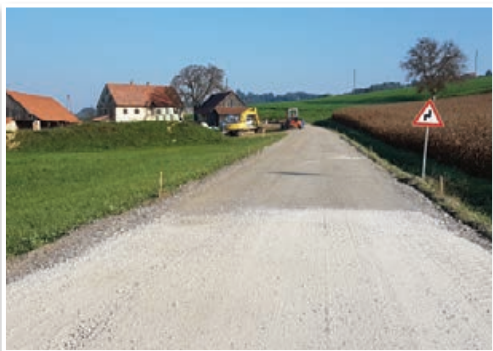
Dela na cestnem odseku Malna-Plodršnica
