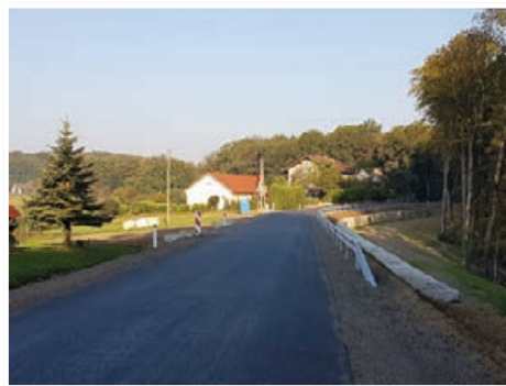
Plaz v Zgornjem Partinju saniran
